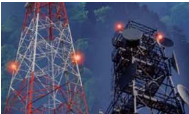
航空障害灯の死活監視
