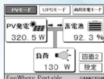
発電状況・電池容量・負荷状況表示例
