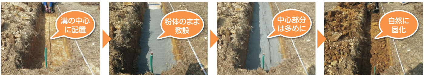
①溝を掘削し接地線を敷設 ②バイオサンアースを敷設 (3m/1袋) ③バイオサンアースを整える ④埋戻し
