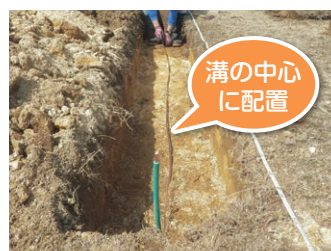
①溝を掘削し接地線を敷設
