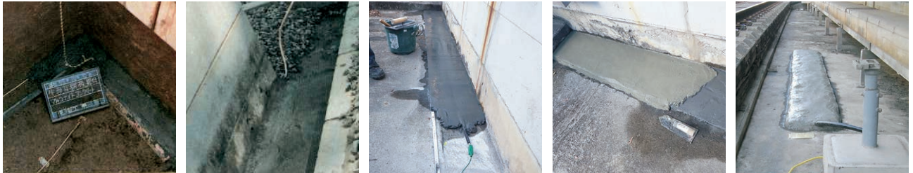
サンアースM5Cの打設 ※M5C:25kg入り(1袋)で、約3m施工できます。(幅30cm)
