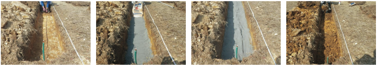
① 溝を掘削し接地線を敷設
