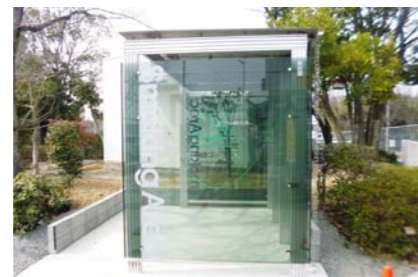
高速道路のSAやPA(太陽光発電・蓄電システム)
