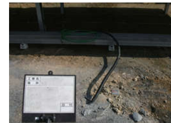
サンアース帯状工法 (施工後)
