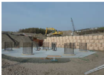
サンアース帯状工法 (施工後)
