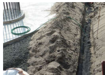
IV線の立上げ (基礎鉄筋と接続)
