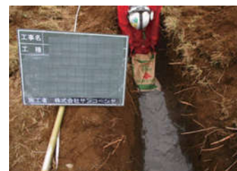
サンアース帯状工法 (施工中)
