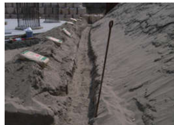
サンアース帯状工法 (施工前)
