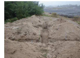
サンアース帯状工法 (施工前)
