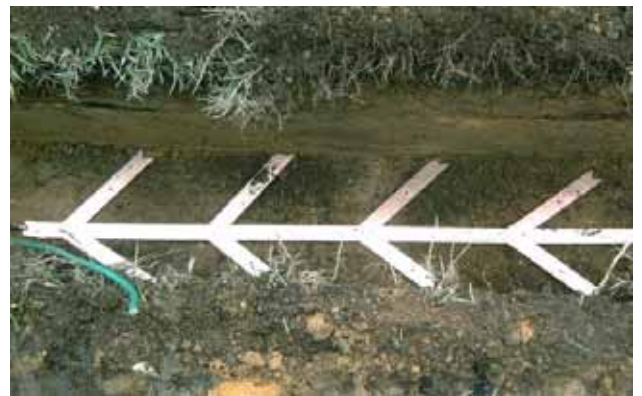
羽根付アースと針タイプ棒の 定常接地抵抗と過渡接地抵抗（サージインピーダンス）
